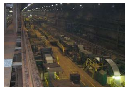
Proizvodna hala A - pogled iz žerjava
