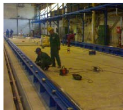
Montaža tekalne proge
