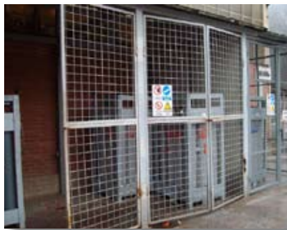
Zunanje skladiščenje rezalnih plinov
