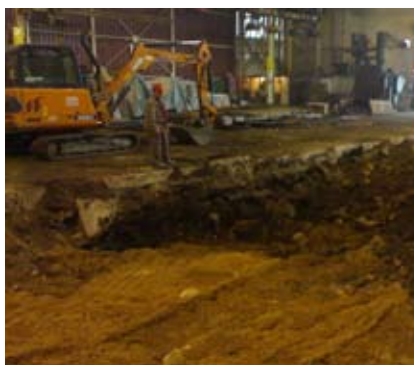
Izkop žlindre po demontaži obstoječih rezalnikov
