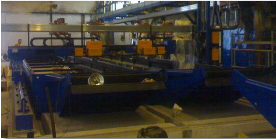
Vodne mize in rezalni most NC1 med montažo
