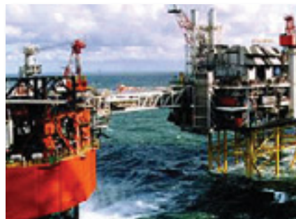
Slika 3: Zahtevne konstrukcije naftne ploščadi so izdelane iz visokotrdnih mikrolegiranih jekel.
