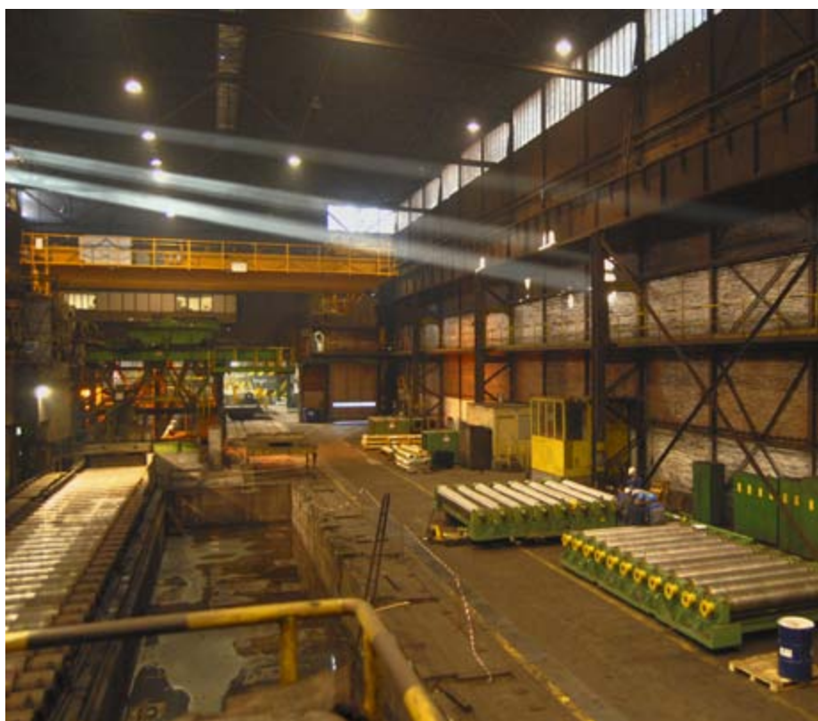
Novi 145-tonski žerjav v ozadju in že sestavljene valjčne mize na desni strani
