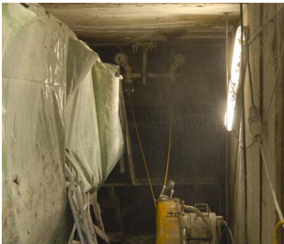
Rezanje betonskega bloka v tunelu pod ogrodjem Bluming
