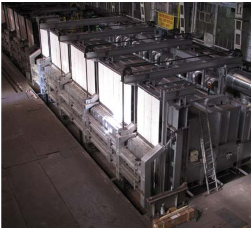
• Nova peč tik pred zaključkom montaže
