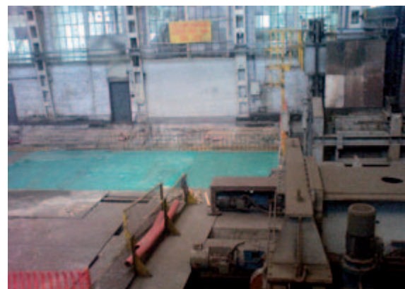
● Slika 5: Temelji za novo tretjo peč Bosio, kjer je bila še pred kratkim zakladalna miza, desno zakladalni voz in peč Wellman 1
