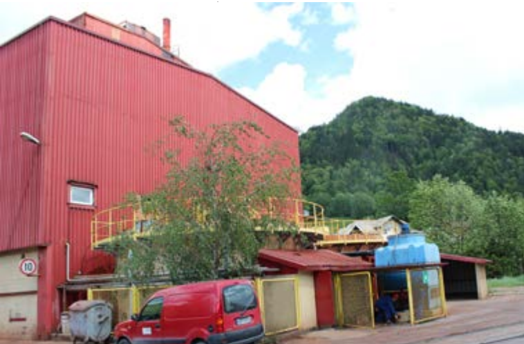
▲ Na iztoku V6 (Nevtralizacija HP) se bo izvedel monitoring odpadne vode.
