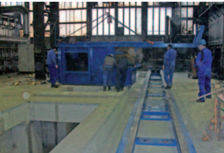
▲ Montaža spodnjega nosilca glave in lijaka odbruskov brusilnega stroja v Težki kovačnici Metala Ravne
