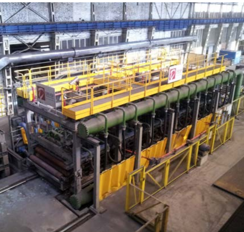
▼ Zaključek montaže nove hladilne naprave
