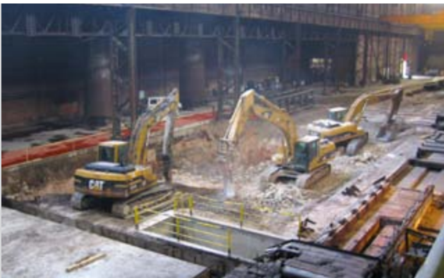
▶ Začetek gradbenih del
