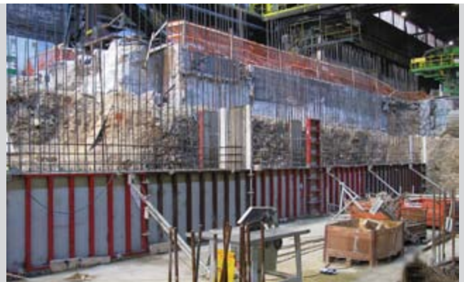
▶ Pogled s spodnjega nivoja kleti strojnice PH1 na koti -6 m
