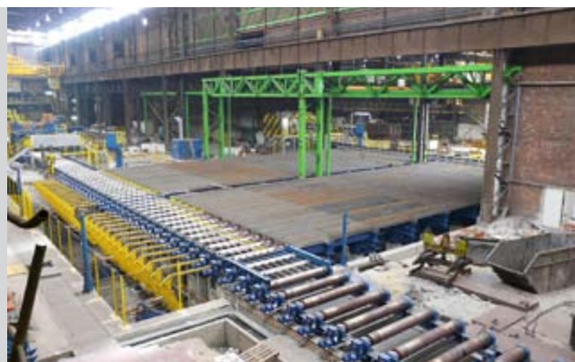
▶ Del linije z vstopnim delom hladilnih miz in s pogledom na spremenjeno konstrukcijo hale
