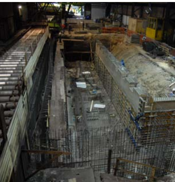
▀ Gradbišče, kjer bodo vgrajene črpalke za nov odškajevalnik na novem valjavskem ogrodju Bluming
