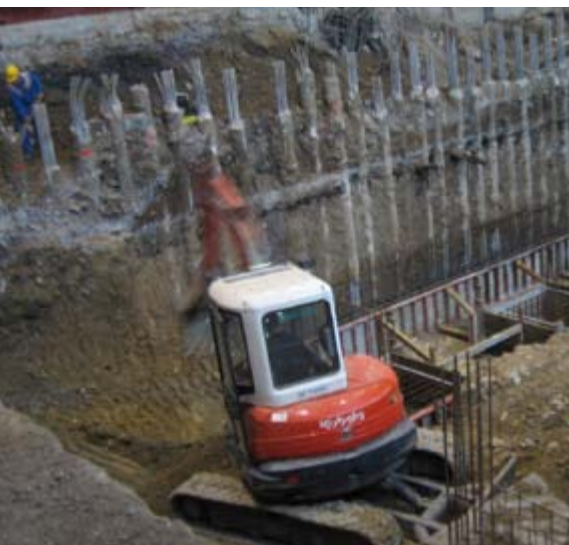
▶ Pilotiranje gradbene jame in dokončanje izkopov
