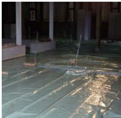
▲ Temelji mlinov ter nova tla v proizvodnji
