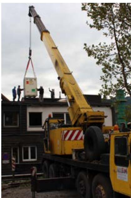
Transport novega mikroskopa v objekt s pomočjo avtodvigala
