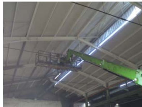
▲ Prenovljena streha proizvodne hale
