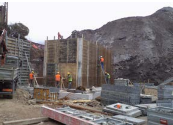
▲ Gradnja temeljev vsipnega lijaka
