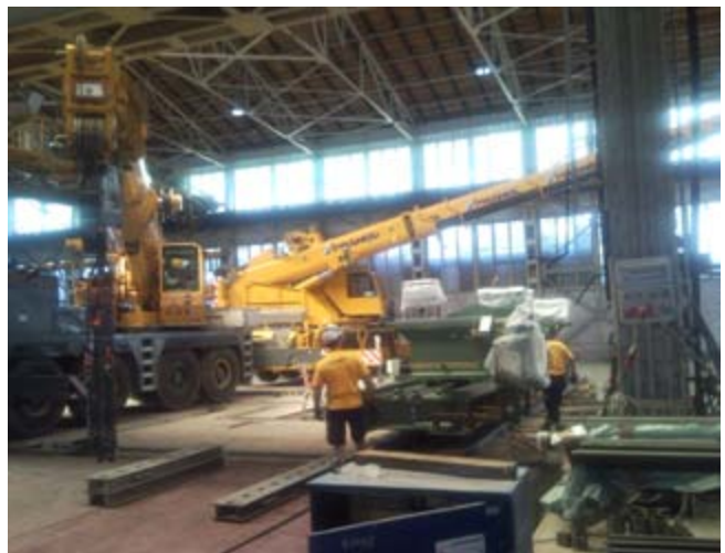
▸ Avtovidgala nameščajo 50-tonsko podnožje krožnih škarij
