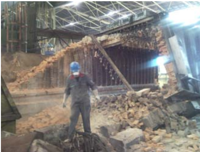
▸ Rušitev Ebnerjeve komorne žarilne peči
