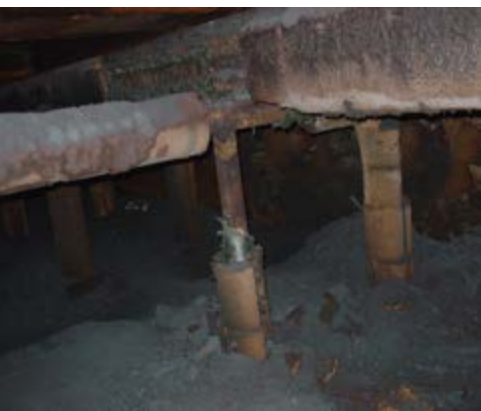
▲ Drsne cevi pred popravilom
