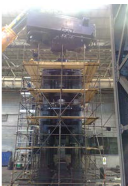
Demontaža rezervoarja z vrha 40/45 MN stiskalnice
