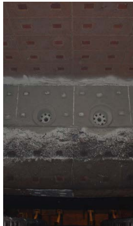
▲ Obnovljena ognjezdružna obzidava čelne stene
