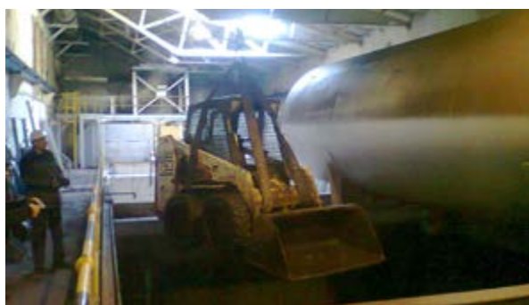
• Spuščanje mini nakladalnika v hladilni bazen na čiščenje
