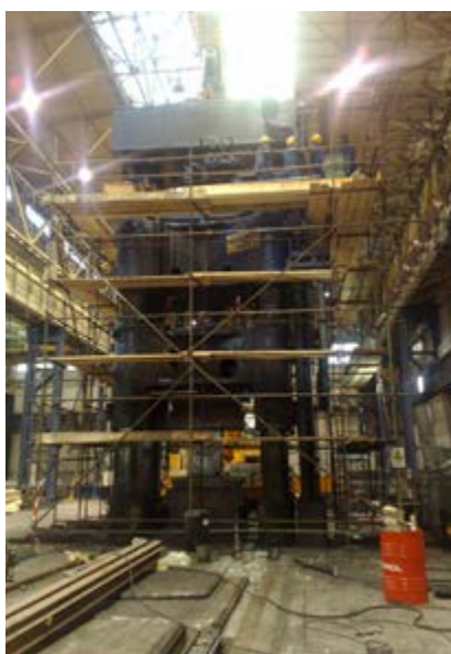
Montaža rezervoarja na vrh 40/45 MN stiskalnice
