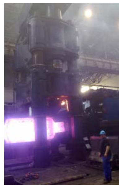
Uspešen ponoven zagon 40/45 MN stiskalnice po končanem remontu
