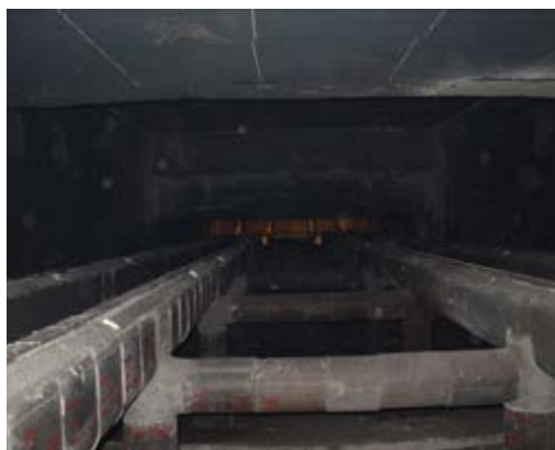
▲ Peč po popravilih
