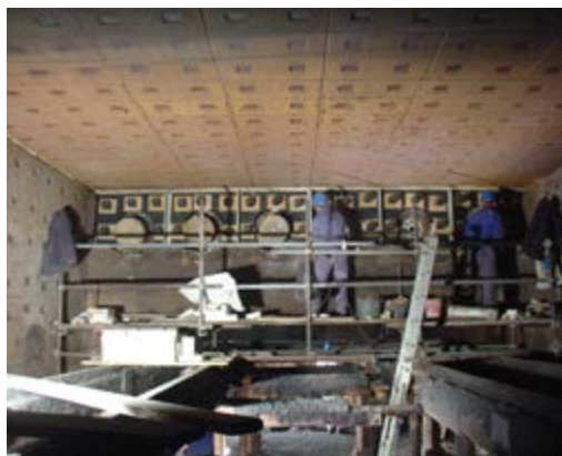
▲ Menjava ognjezdružne obzidave v čelni steni
