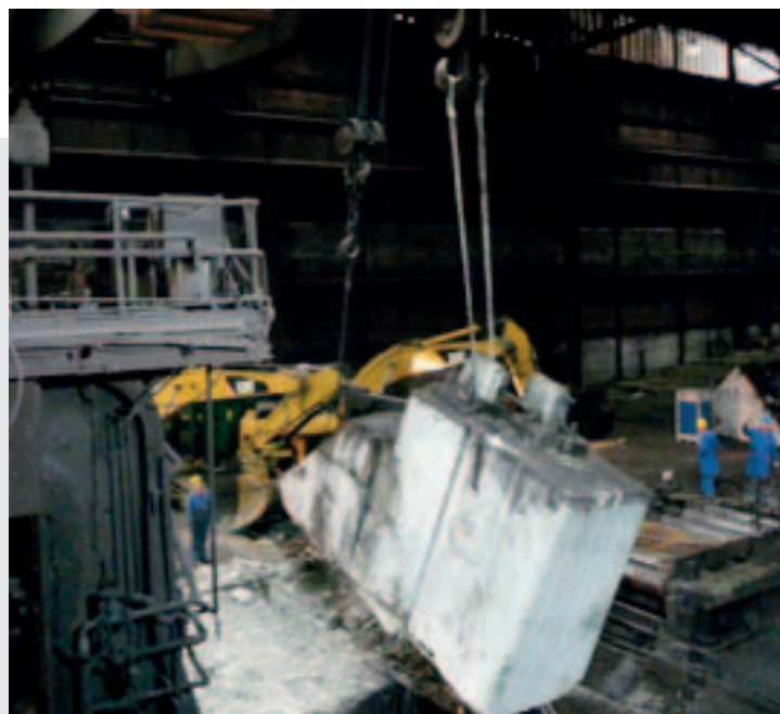
▶ Dvigovanje 80-tonskega betonskega bloka
