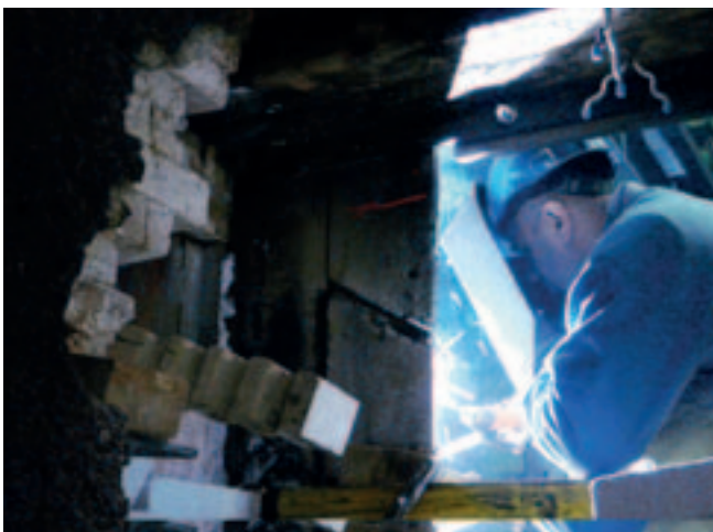
• Dela v potisni peči v vroči valjarni
