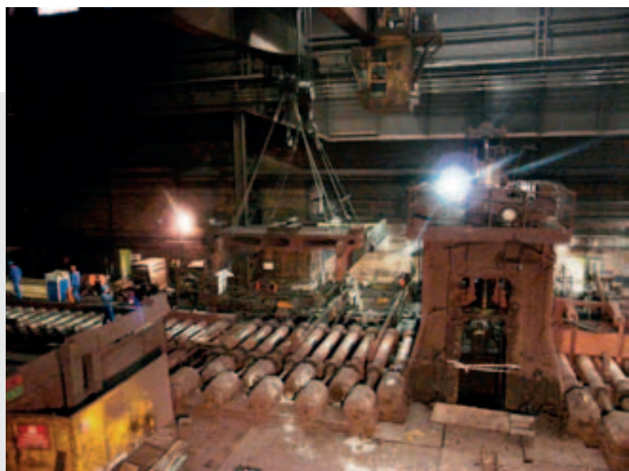
▶ Demontaža stare opreme v polnem teku
