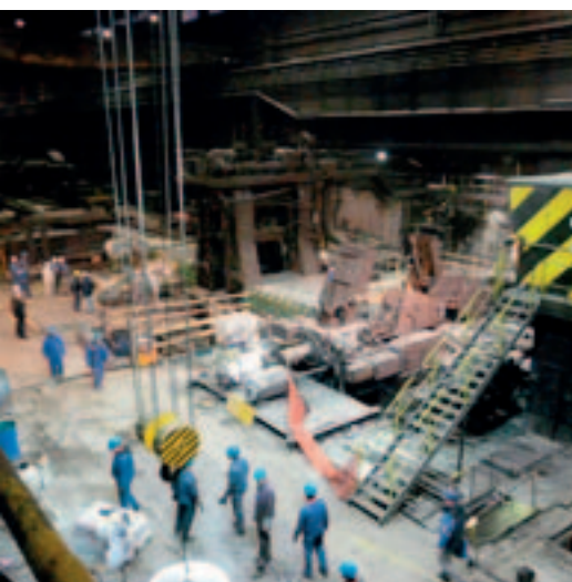
Nove valjčnice vgrajene
