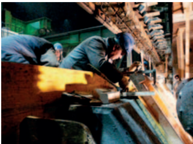
• Dela na izstopni steni potisne peči
