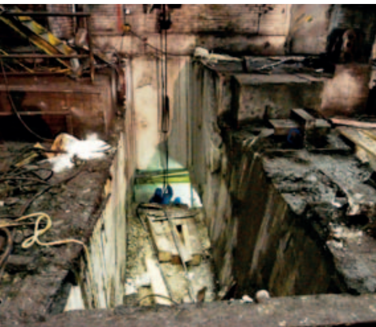
▶ Luknja v obstoječem temelju po dvigu 80-tonskega bloka
