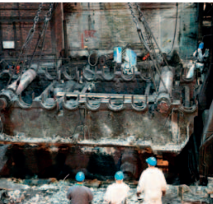
▶ Valjčna miza za ogrodjem uspešno iztrgana iz betona
