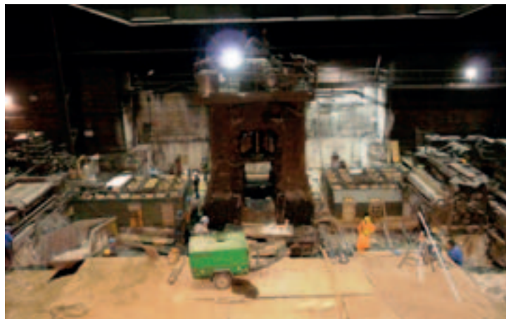
▶ Nova temelja vodil na pogonski strani in stene ter stebri oljnih kleti, pripravljene za betoniranje
