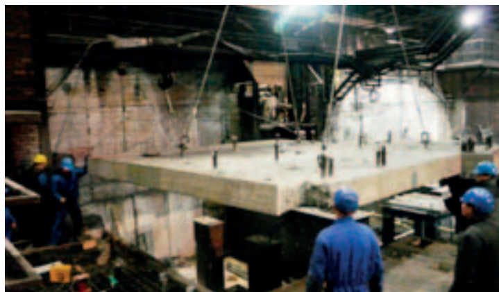
▶ Montaža zgornje plošče oljne kleti št. 7
